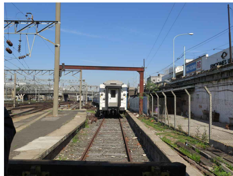
51 - Vías Ferrocarril Gral. Roca al Sur de Estación Constitución
