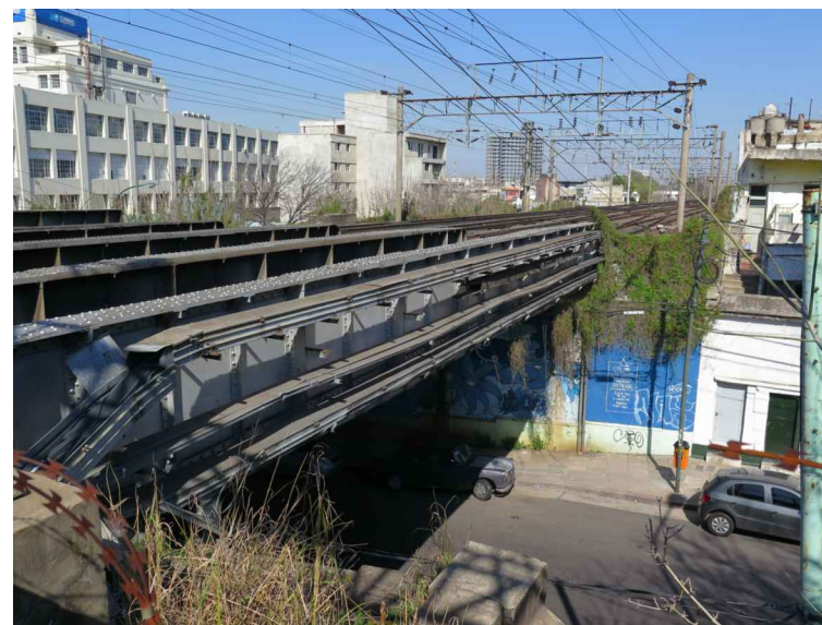
45 - Vías FFCC Gral. Roca Sobre Calle Brandsen
