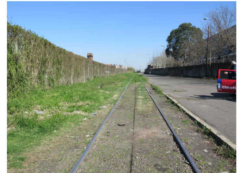
33 - Estación Sola plaza Oeste y Av. Velez Sarsfield
