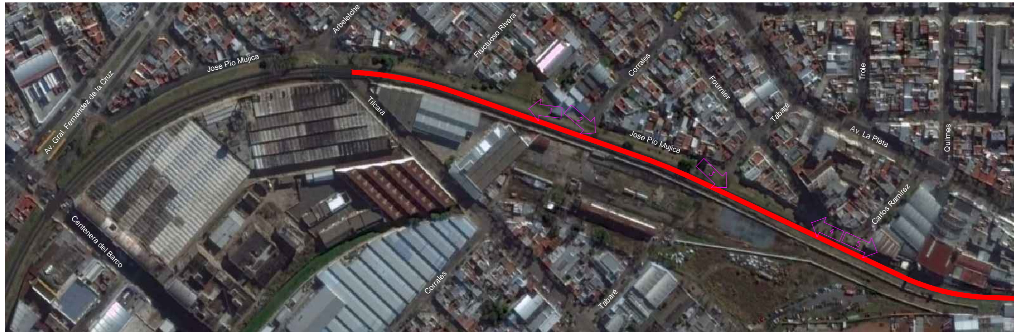
01- Vías FFCC Gral. Belgrano Sur a 50m de Calle Corrales
